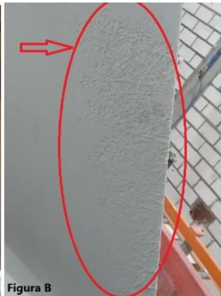
Figura 12 - Defeito em luz específica (A) e Defeito de ar na cabeceira em luz ambiente (B)
