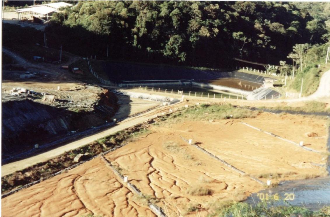
**ATERRO SANITÁRIO:** local onde existe adequada impermeabilização do solo antes do início da disposição do lixo (atende as normas legais).
