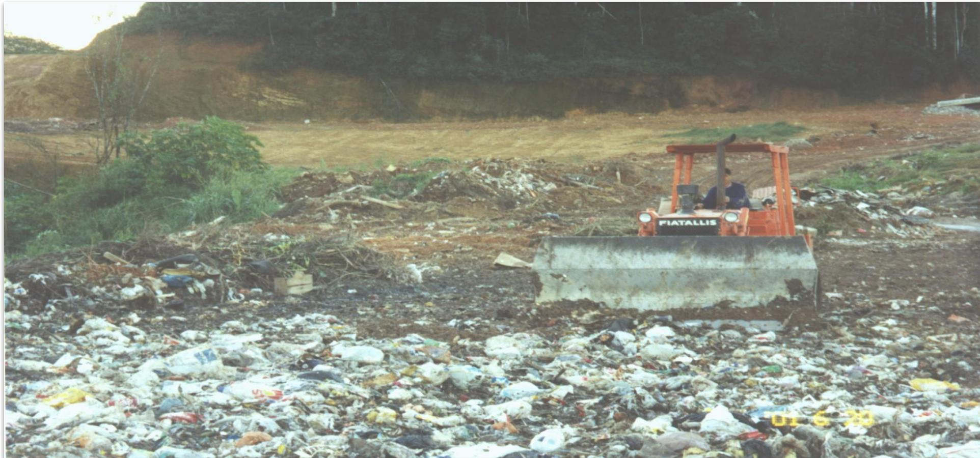
**ATERRO CONTROLADO:** local onde o lixo é despejado sobre o solo e coberto de terra à medida que vai sendo compactado por tratores.
