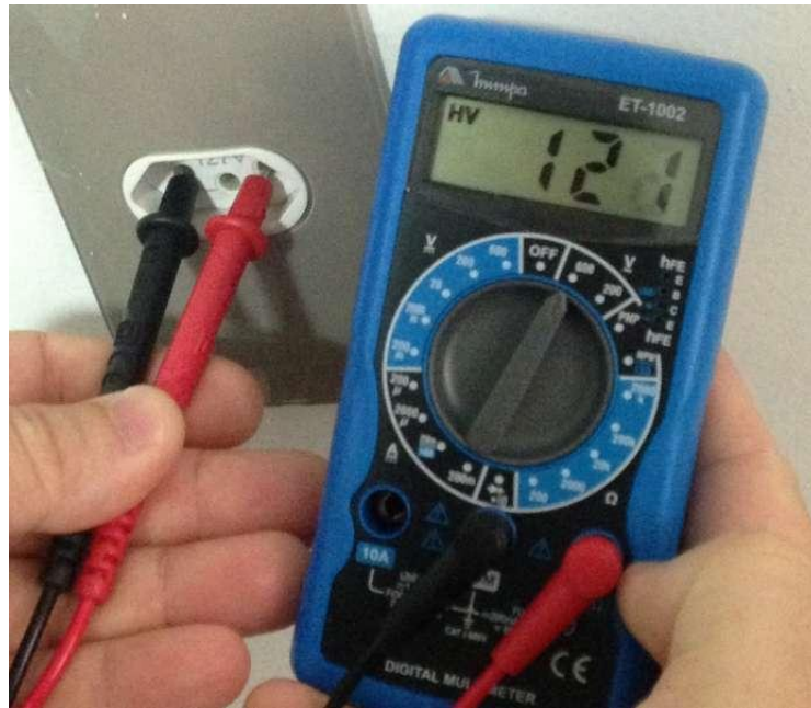
Usando o multímetro para medir tensão na tomada
